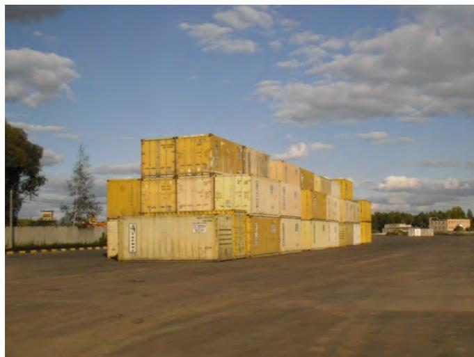
ная площадка № 1, площадью 2 га, вместимость 1300 ДФЭ, розетки для подключения КРК на 60 ед., фронт выгрузки 1100 м (единовременная обработка УКП 71 у.е.), перегрузочная техника – 2 ричстакера грузоподъемностью 45 т, 2 фронтальных штабелера для порожних контейнеров.
