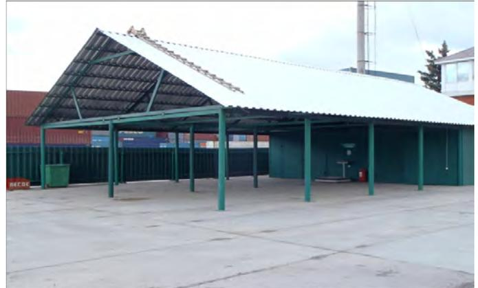
досмотровой рентгентелевизионной установки и крытое место (навес) для таможенного досмотра площадью 143 кв. метров.
