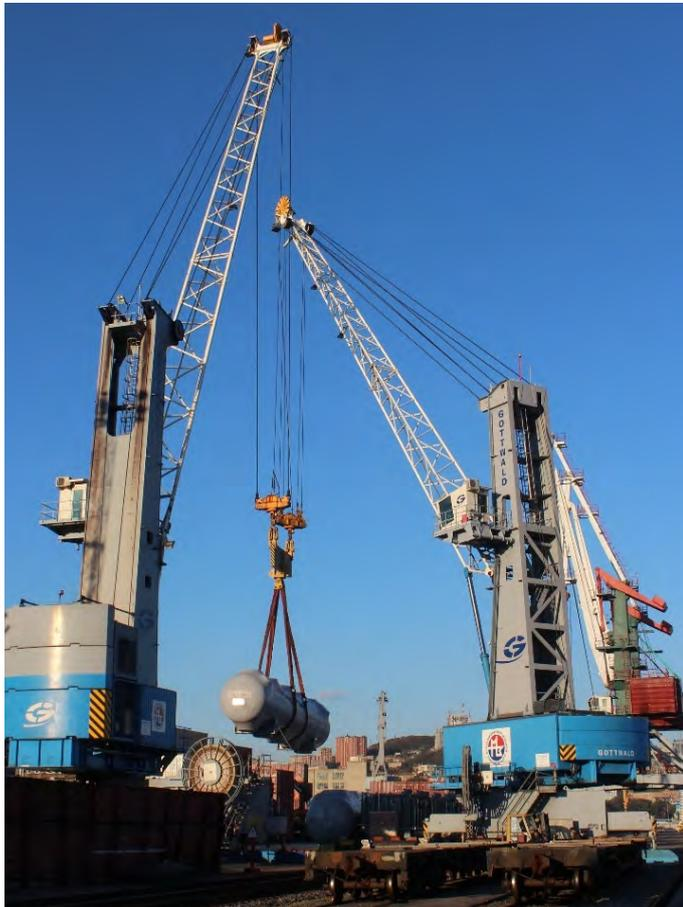
В процессе были задействованы два мобильных крана «Gottwald», грузоподъемностью 100 т и 63 т.
